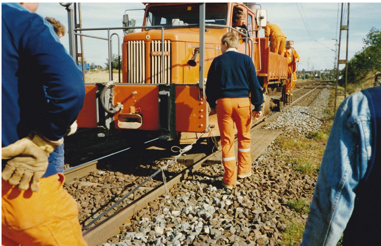
Utdragning av kabeln med hjälp av motorvagn
