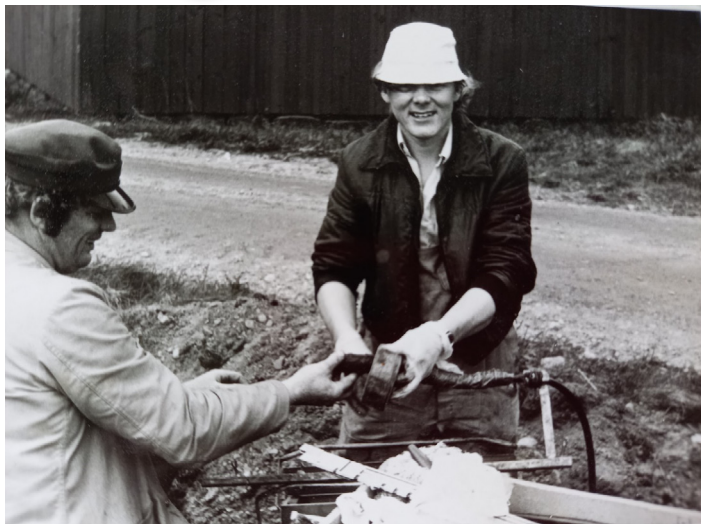
Helås i Vara kommun våren 1979. Kent Brolin klettar in en 50 pars CHE-kabel under överinseende av Ove Johansson.
