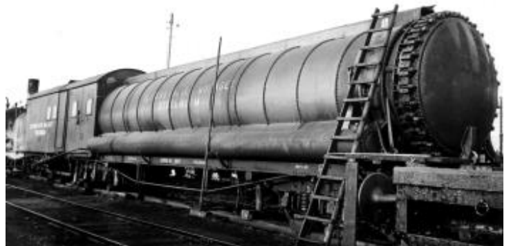
Tab för impregnering av stolpar lämnar Töreboda 1939. 15 000 stolpar hade impregnerats.
