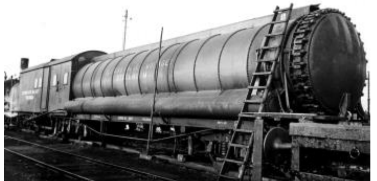
Tab för impregnering av stolpar lämna Töreboda 1939. 15 000 stolpar hade impregnerats.
