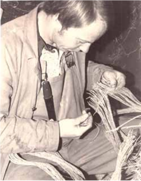
Tommy Körnsberg skarvar kabelpar.
