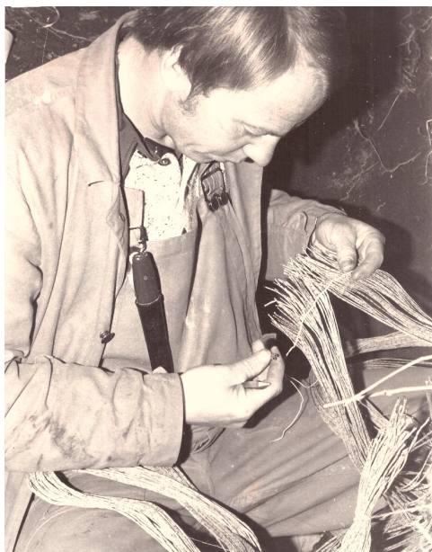
Tommy Körnsberg skarvar kabelpar.
