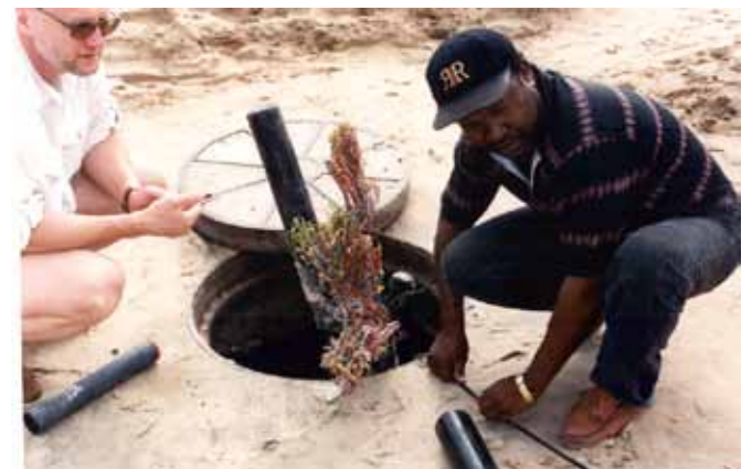
Sören och kabelreparatör Andersson vid ett manhole
