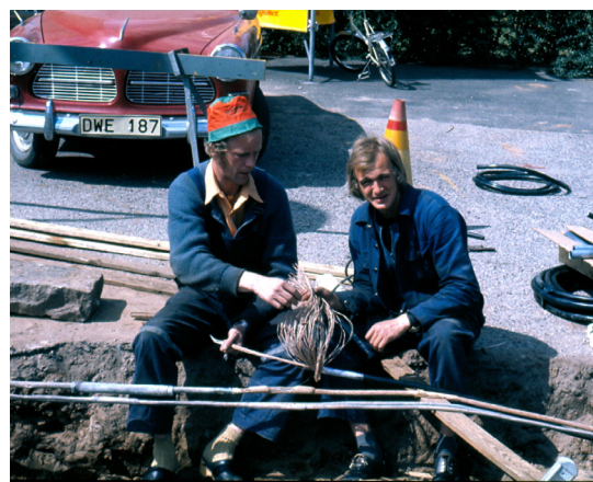
Loffe o Conny skarvar PME kabel
